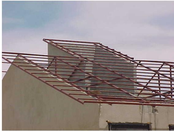
*Figura 5: Estrutura de telhado em aço, substituindo o tradicional madeiramento - Conjunto habitacional Tom Jobim – Rio de Janeiro (Fonte: Linhares, 2005).*
