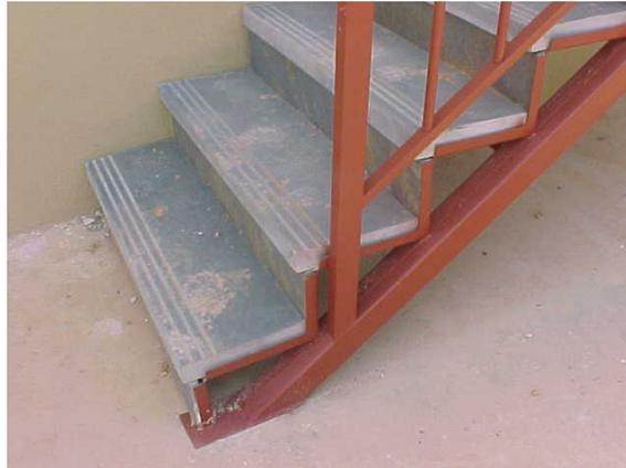
*Figura 4: Escada com estrutura em aço, substituindo as escadas em concreto armado - Conjunto habitacional Tom Jobim – Rio de Janeiro (Fonte: Linhares, 2005).*
