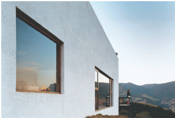
Figura 5. Vista externa da casa Mantiqueira do escritório Brasil Arquitetura. São Paulo, Brasil, 2001.
