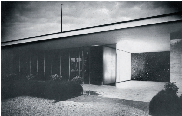
Figura 15. Armario de luz en el pabellón alemán de Barcelona.
