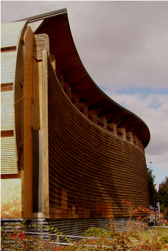
Figura 2. Pabellón Expo Sevilla.
