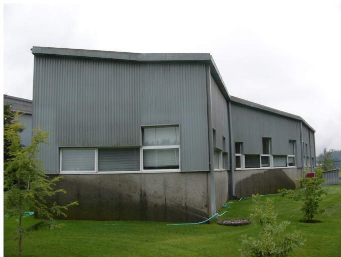
Figura 15. Exterior sur oficinas.
