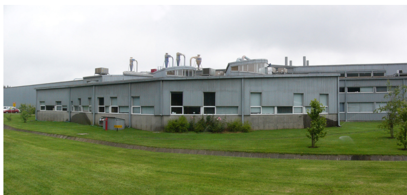
Figura 5. Exterior oficinas y nave de producción.
