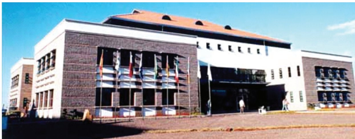
Figura 5. Polo Cultural de Erechim – sistema de proteção solar reforça o caráter do edifício (ArcoWeb, s.d.).
