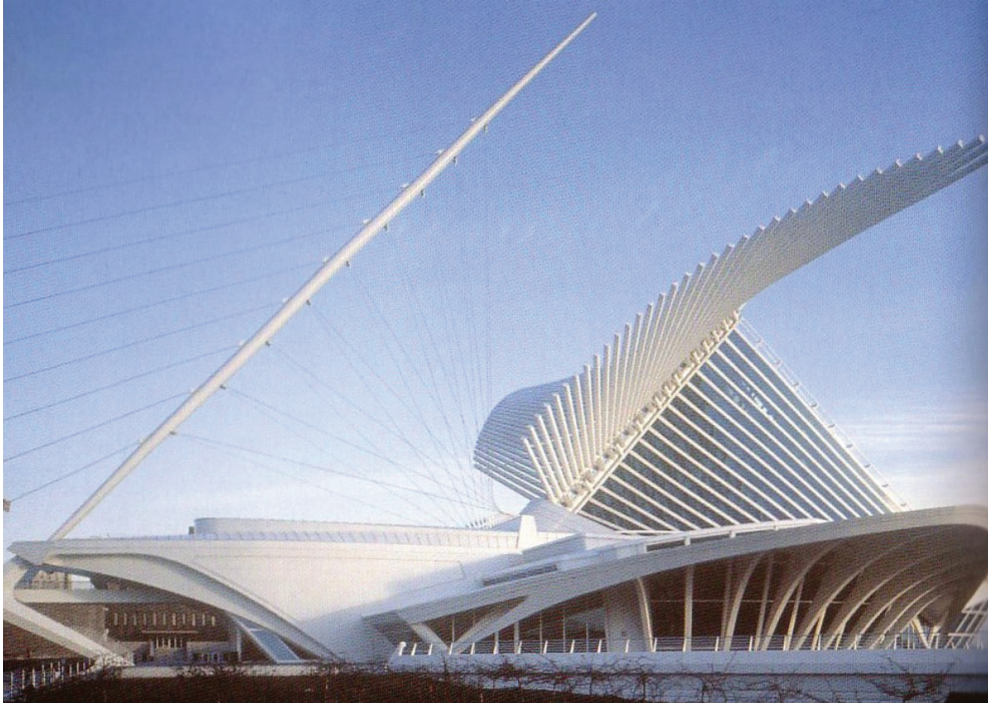
Figura 3. Brise-soleil dinamizando a composição do edifício – Milwaukee Museum, Estados Unidos, 2001 (Jodídio, 2003).
